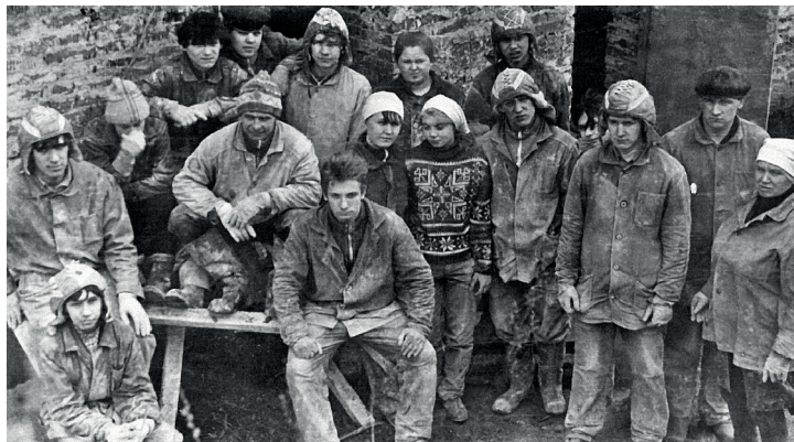
Бригада строителей-отделочников, практикантов ПУ-63 (архив музея КузТАУиС)
